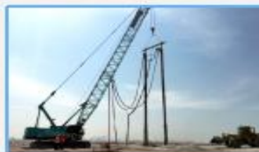
迪拜德拉群岛开发振冲挤密桩
