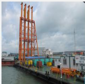
港珠澳大桥香港人工岛
