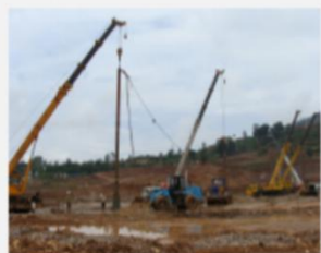
普渡河鲁基厂水电站
