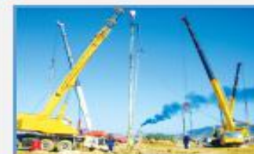
阿尔及利亚skikda 500万吨年凝析油项目基础处理振冲桩
