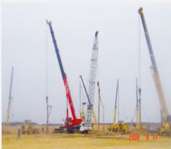
定州定州电厂240米高烟囱
