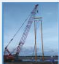
孟加拉火电站基础建设振冲挤密桩
