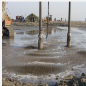
曹妃甸原油储油罐基础
