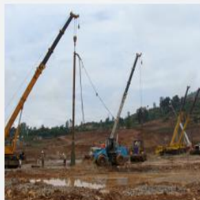
普渡河鲁基厂水电站
