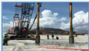
马来西亚关丹港新的深水码头填海工程1期
