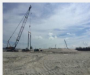
马来西亚双轨道铁道工程
